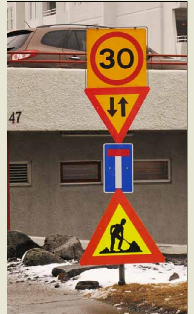
Þessi merking er við vinnusvæði í vesturbæ Reykjavíkur. Þarna hefur einstefnugötu verið lokað að hluta og tekin upp tímabundin tvístefna. Ágæt merking en samt er eitthvað ekki alveg eins og það á að vera.
